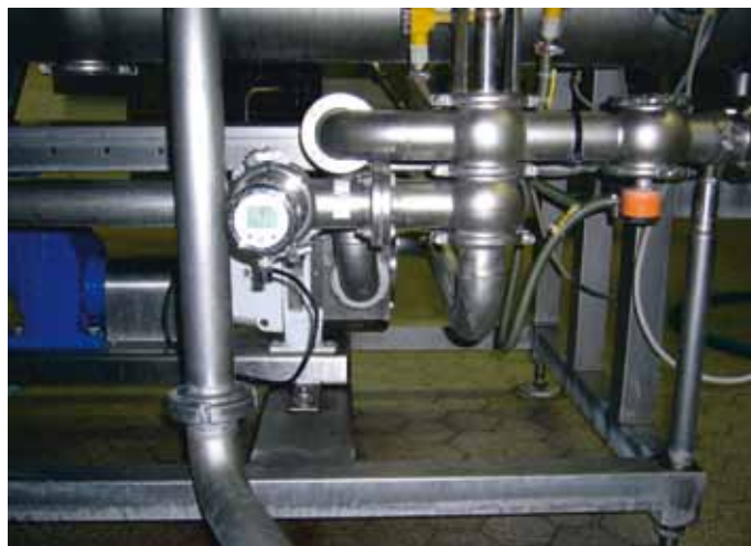
Abb. 2 Trübungsmessung in der Hefeverkaufsleitung
