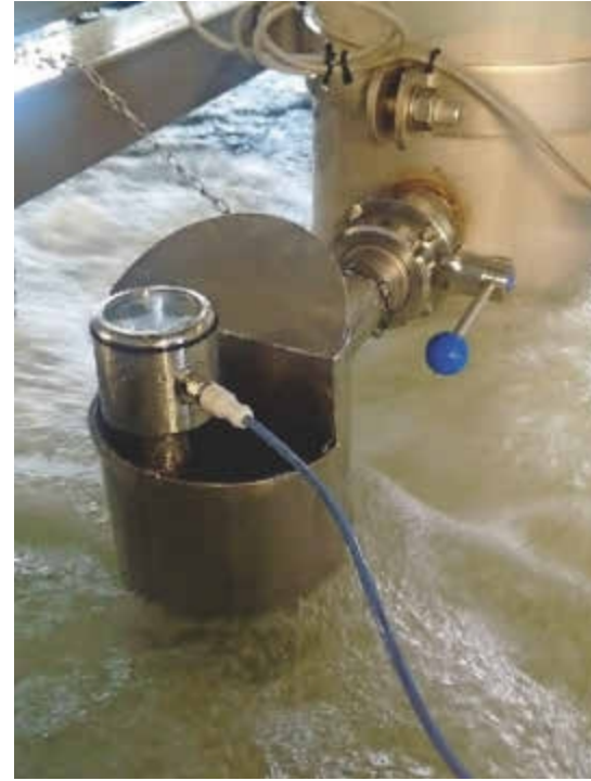
Die Trübungsmessung im Eiswasserbehälter ermöglicht der DMK die Vermeidung einer Kontamination des Endproduktes Milch
