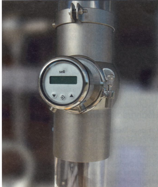
Einbau des Sensors in einer Rohrleitung
